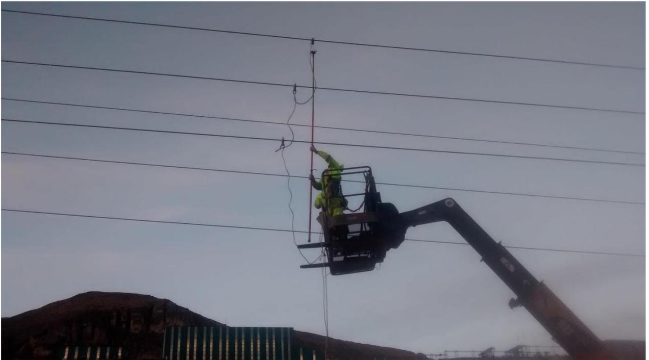
**FIG.29 ATERRAMIENTO DE LA LINEA PREVIO AL CAMBIO DE CONDUCTOR (FUENTE PROPIA)**
